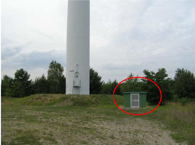
Abb. 2.4.2/1: WEA mit außenanliegendem Transformator
