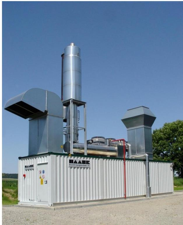
**Abb. 4.3.6/3:** Gasnotfackel auf einem Blockheizkraftwerk (Quelle: [www.haase-energie technik.de](http://www.haase-energie technik.de))
