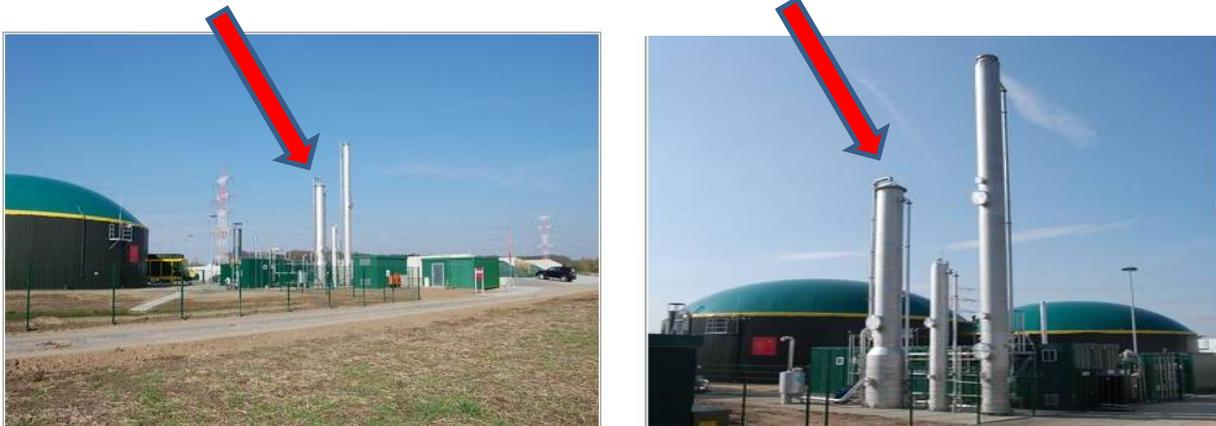
Abb. 4.3.6/4 und 4.3.6/5: Beispiel einer Druckwasserwaschanlage - siehe Pfeil (Quelle; ÖKOBIT GmbH, Abfallforum)
