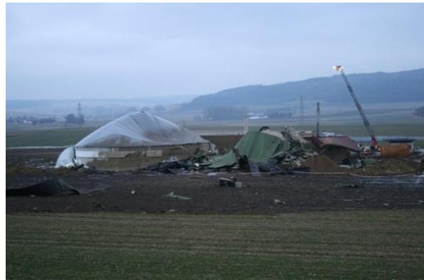
Abb. 4.5.3/1 und 4.5.3/2: Durch eine Explosion zerstörte Biogasanlage (Quelle: www.feuerwehr-riedlingen.de)
