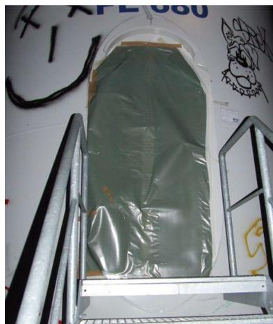
**Abb. 2.4.1/5:** Abdichtung der Zugangstür einer WEA mit Folie und Klebeband (Quelle: Feuerwehr Leopoldshöhe)
