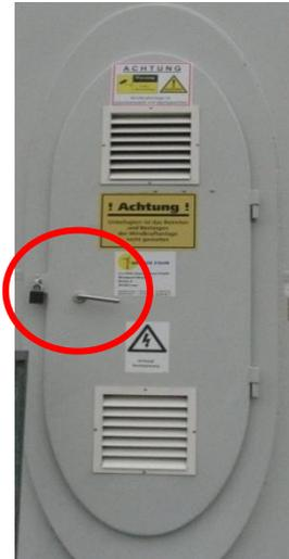
**Abb. 2.4.1/3:** Türsicherung mit Vorhängeschloss
