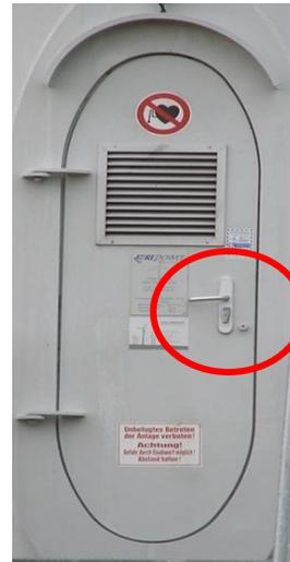
**Abb. 2.4.1/4:** Türsicherung mit Zylinderschloss
