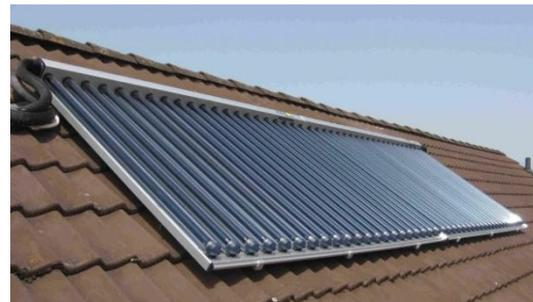
Abb. 3.2.1/3: Vakuumröhrenkollektor (Quelle: [www.fellnergmbh.de](http://www.fellnergmbh.de))
