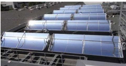
Abb. 3.2.1/4: Parabolrinnenkollektor (Quelle: [www.dlr.de](http://www.dlr.de))
