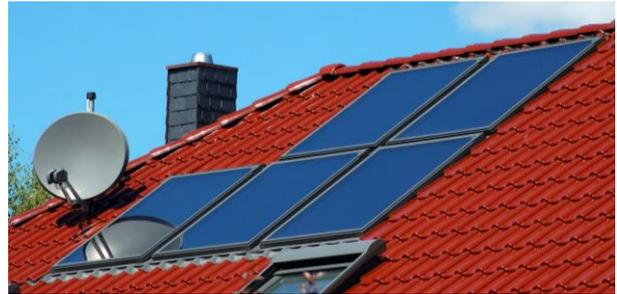
**Abb. 3.3.1/4:** Indachmontage (Quelle: [www.odtec.at](http://www.odtec.at))
