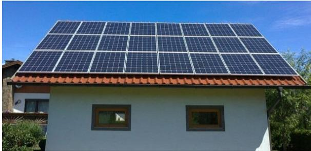
**Abb. 3.3.1/3:** Aufdachmontage (Quelle: [www.oekopower.com](http://www.oekopower.com))
