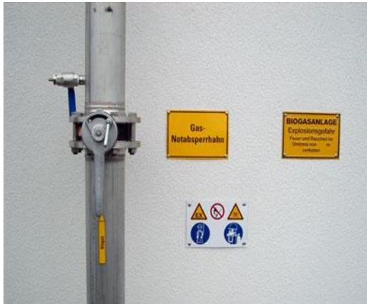
**Abb. 4.3.6/2:** Gas-Notabsperrrhahn (Quelle: [www.lsv.de](http://www.lsv.de))
